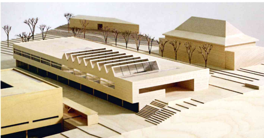
Das Holz-Modell mit Blick von Nordwesten zeigt in der Mitte des Bildes den zweigeschossigen Erweiterungsbau mit den Shedoblichtern.
